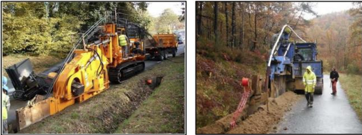
Trancheuse | Exemple de pose de câble à la trancheuse
